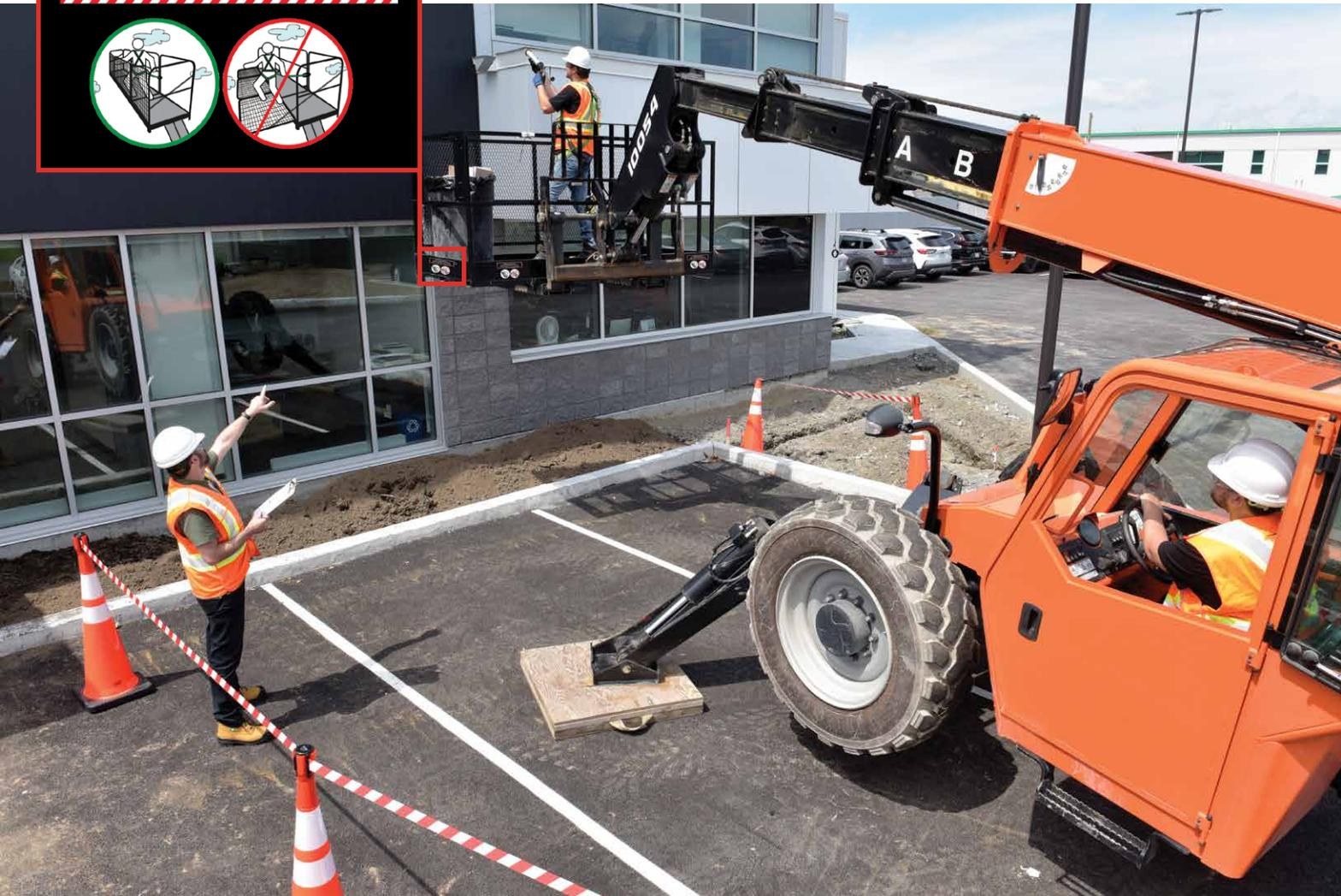
plateforme de travail pour que celui-ci soit porté correctement. De plus, lors de l'utilisation d'une plateforme de travail sur un chariot élévateur, les quatre côtés de celle-ci doivent comporter un garde-corps, tel qu'exigé par le *Code de sécurité pour les travaux de construction (CSTC)*.
