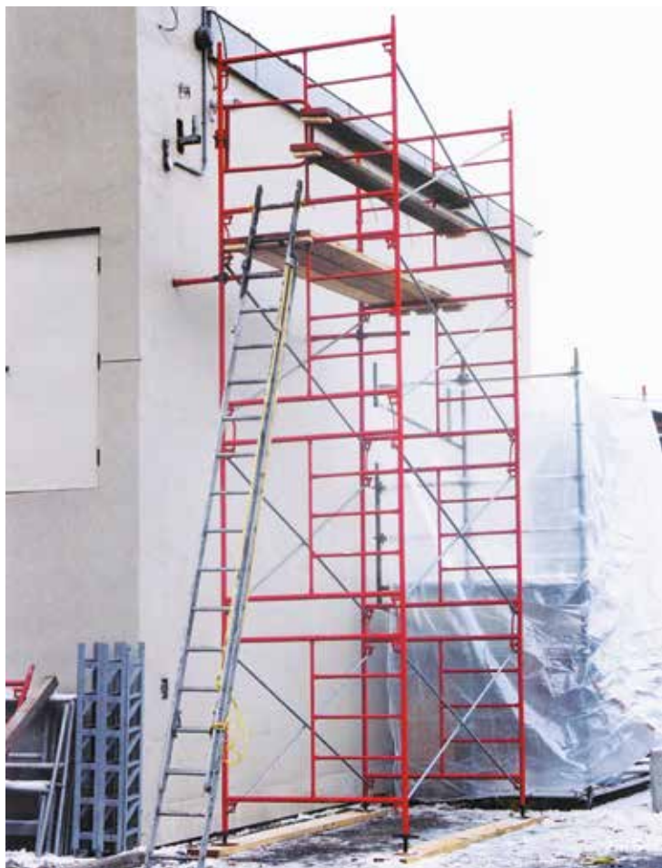
Échafaudage sur cadres métalliques traditionnels
