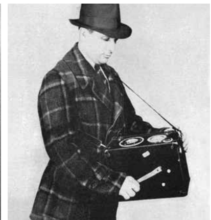
Une autre photo tirée du Manuel de sauvetage et de premiers soins dans les mines de 1951 qui montre un indicateur à main d'oxyde de carbone.
