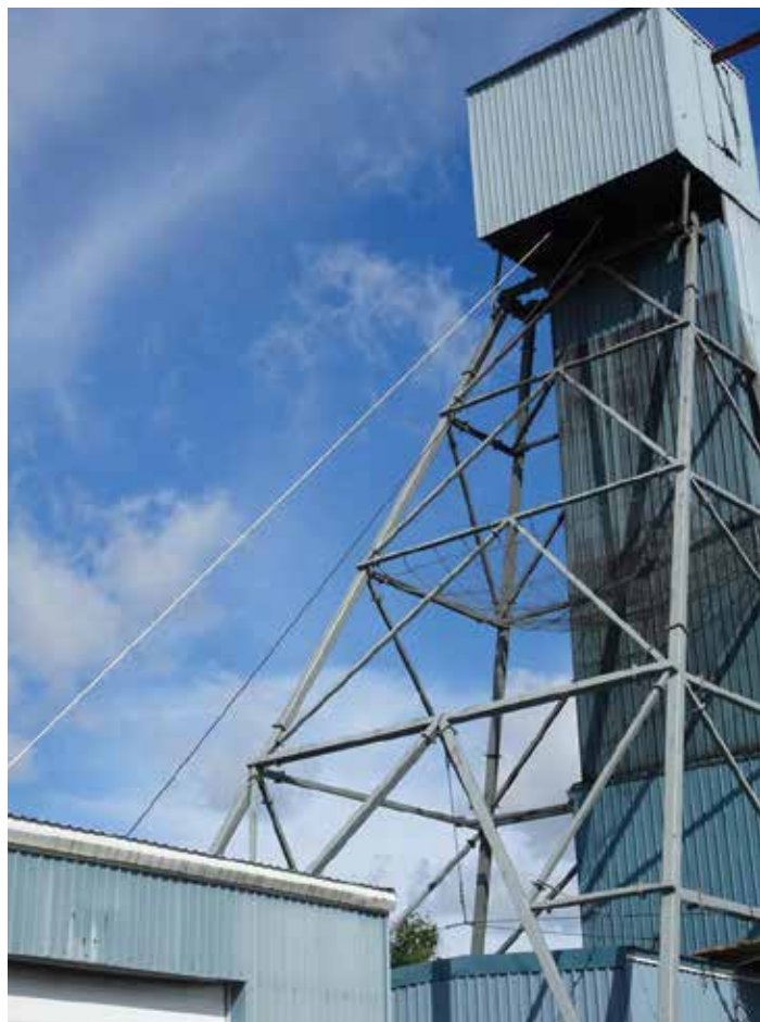
Chevalement du puits 1 de la mine Goldex avec câble synthétique et câble d'acier
