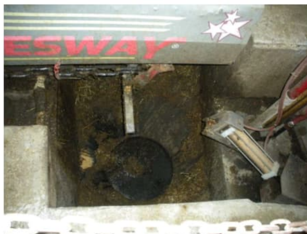
Figure 3 : Ouverture vers le réservoir de l'évacuateur
