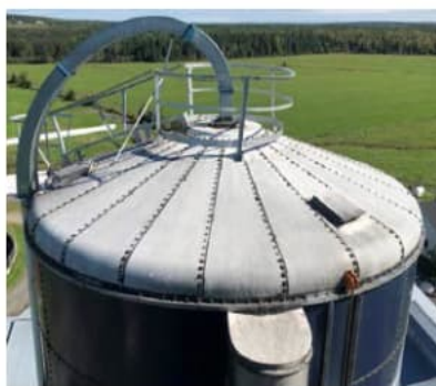
Photos 2 et 3 : Porte d'accès en haut de l'échelle extérieure et événements de toit (Photos : Groupe Gesfor)
