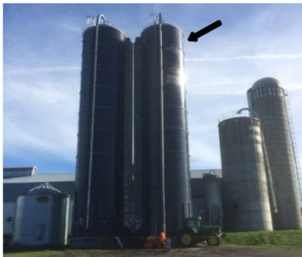
Photo 1 :Silo tour en cause (photo CNESST)
