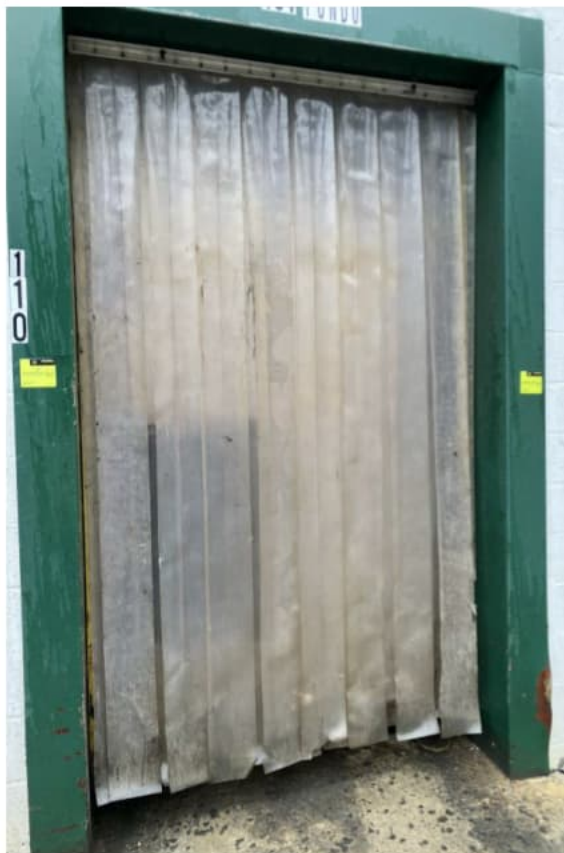
Figure 1 : porte entrée d'une chambre d'entreposage (rideaux en place) Source : CNESST
