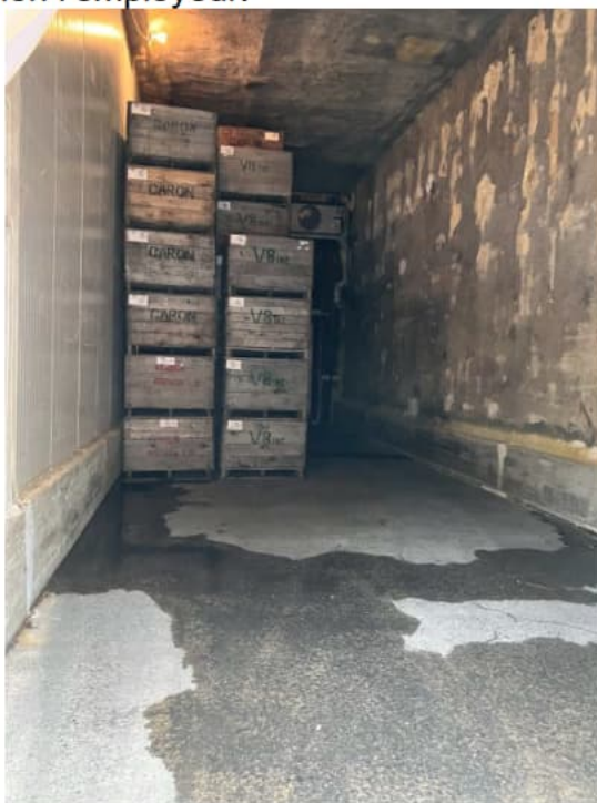
Fig.2 : Intérieur d'une chambre d'entreposage Source : CNESST
