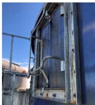
Photos 2 et 3 : Porte d'accès en haut de l'échelle extérieure et événements de toit (Photos : Groupe Gesfor)
