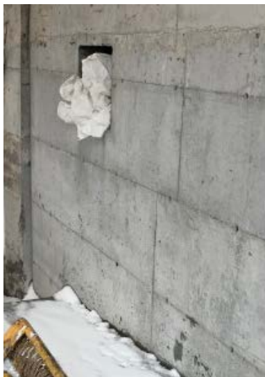
Bâche obturant une des ouvertures – vue de l'extérieur (Source : CNESST)
