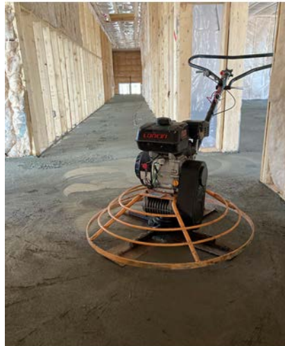
Aplanisseuse de béton (truelle mécanique) à essence utilisée sur le chantier (Source : CNESST)
