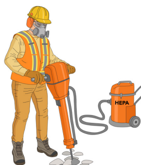
Figure 9 : Marteau-piqueur muni d'un système d'aspiration avec filtre HEPA
