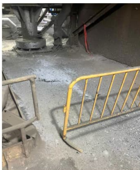
Photo 2 : espace à côté de la chute à plomb du four 1.
