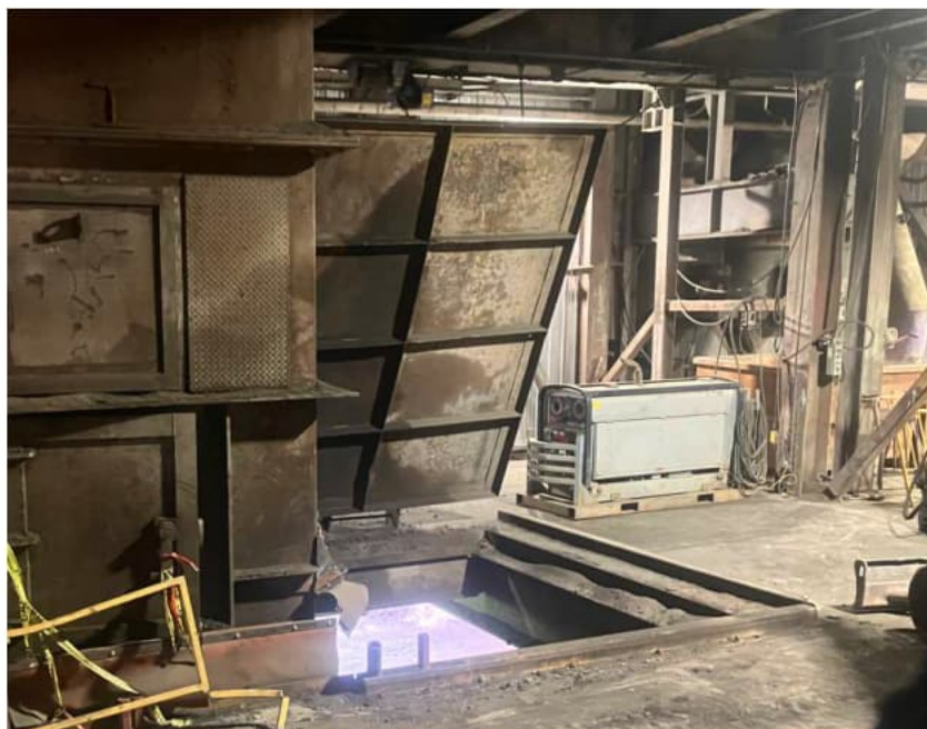
Photo 1 : trappe (chute à scories au four #2)
