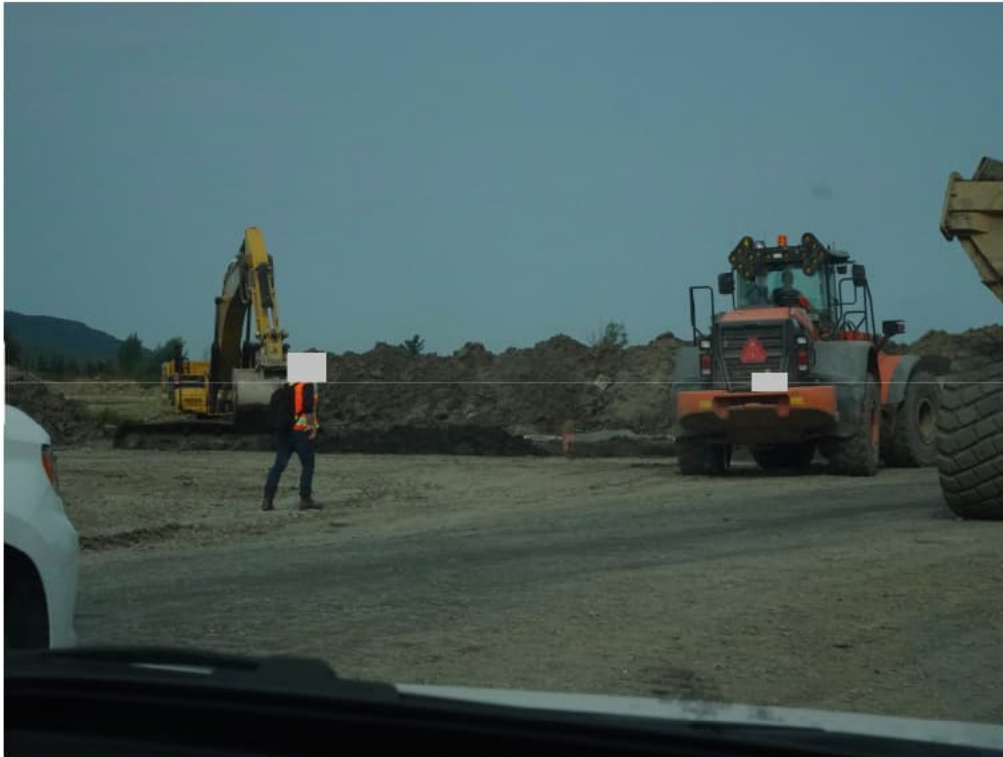
Photo 1 : L'un des deux travailleurs de ABS qui circule à pied d'œuvre sur le chantier et qui côtoie de la machinerie lourde dans la voie de circulation principale (Source : CNESST)
