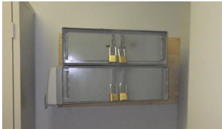
Photo 1 : Boîtiers fixés au mur dans la salle de désarmement au Palais de justice de Mont-Joli. Source : CNESST, 27 juillet 2018.
