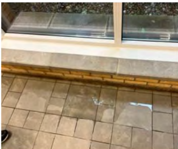
corridor sous sol 1
