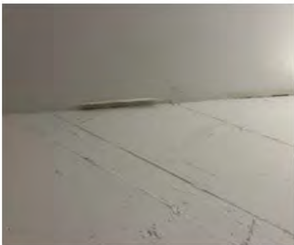
cage escalier ( celle près du bureau)
