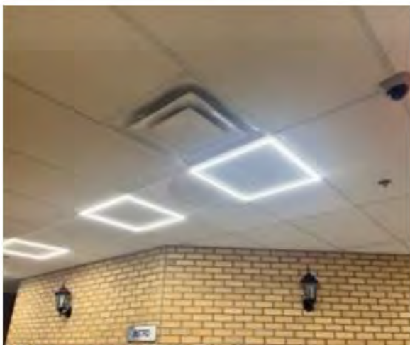
Plafond corridor SS1
