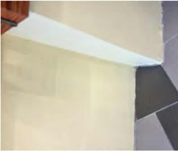
corridor 4eme près porte terrasse
