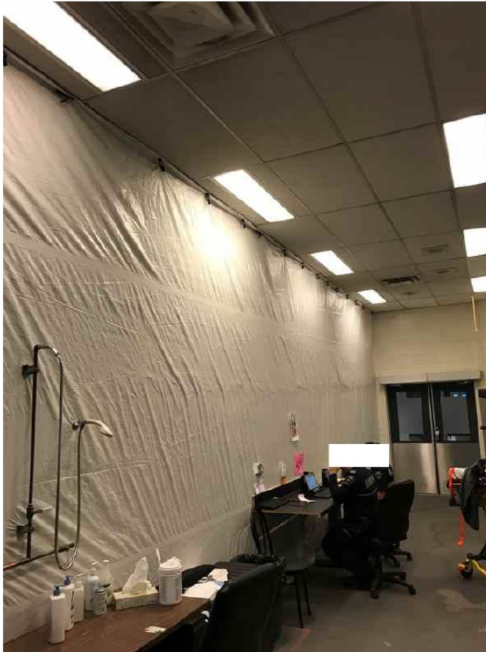
Photo 1 : Poste de travail et mur de confinement (source CNESST 2019-10-01)
