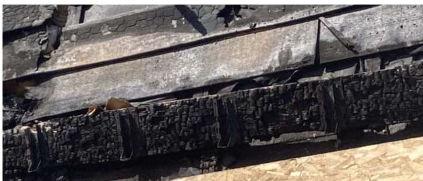
Photo de la lisse et des équerres
