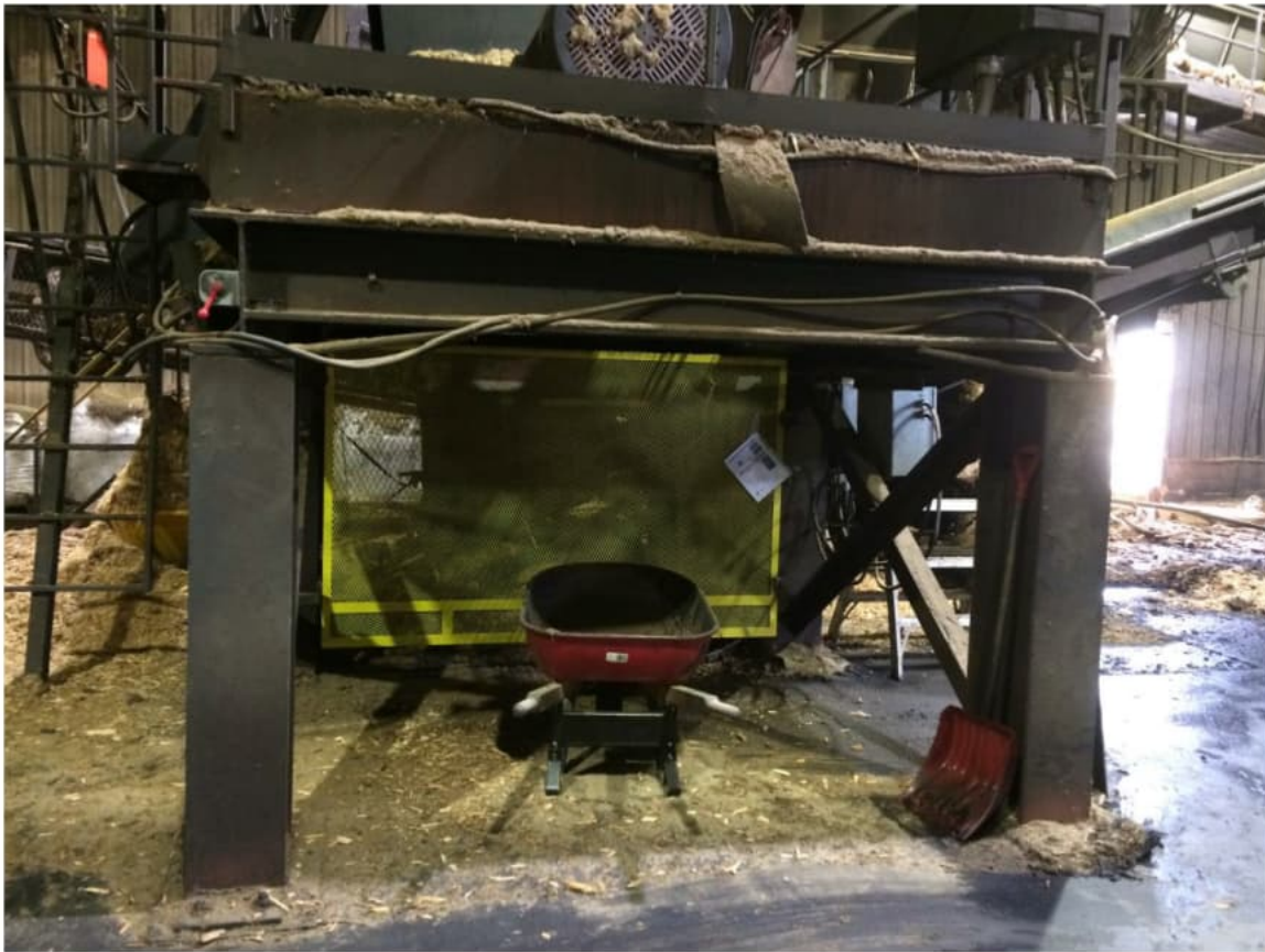
Protecteur de maintien à distance (enceinte) Convoyeur de sortie du broyeur 2 Sous la structure du broyeur 2 -Après- Source : CNESST
