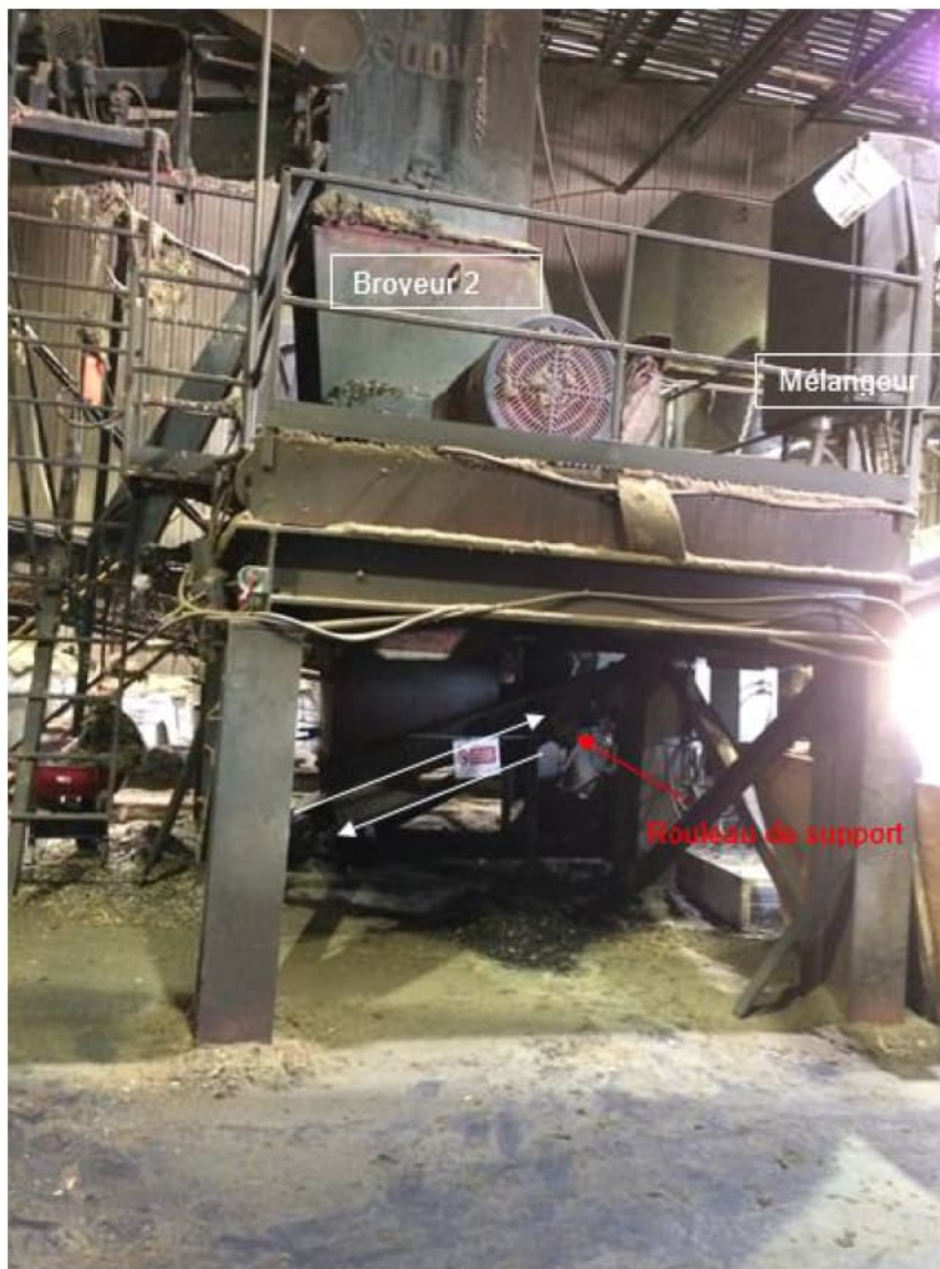
Convoyeur de sortie du broyeur 2 Sous la structure du broyeur 2 Source : CNESST
