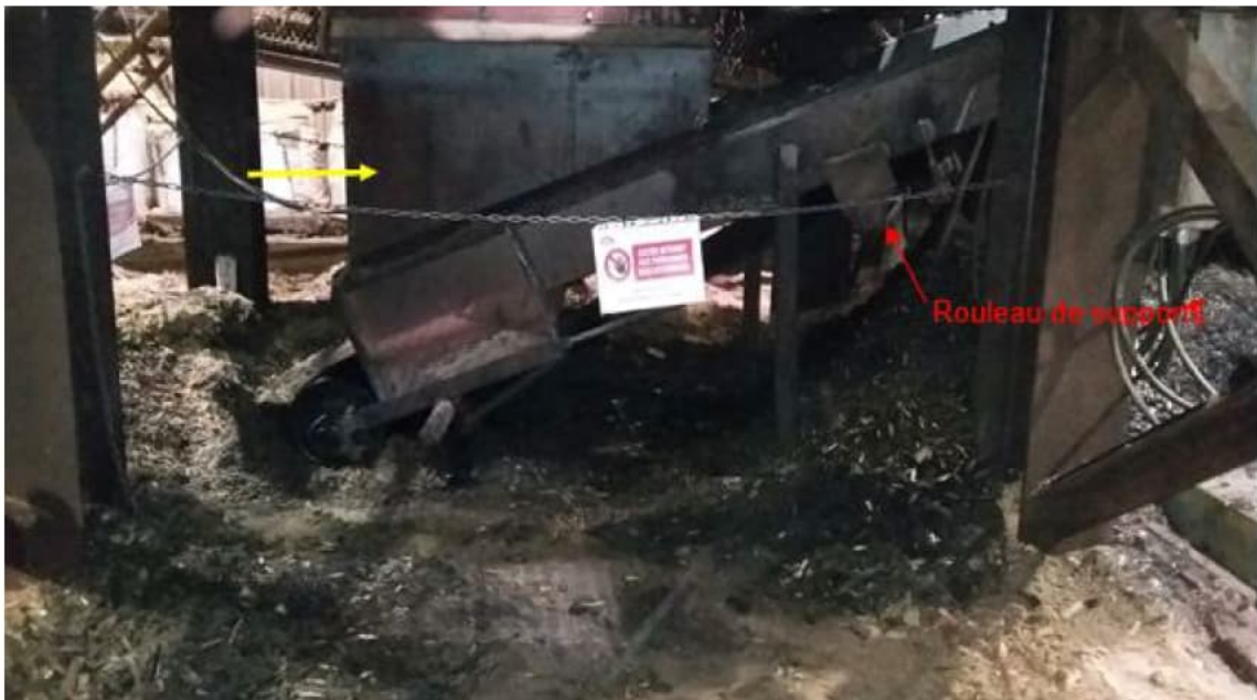
Convoyeur de sortie du broyeur 2 Rouleau de support Accès à la chute du broyeur 2 Source : CNESST
