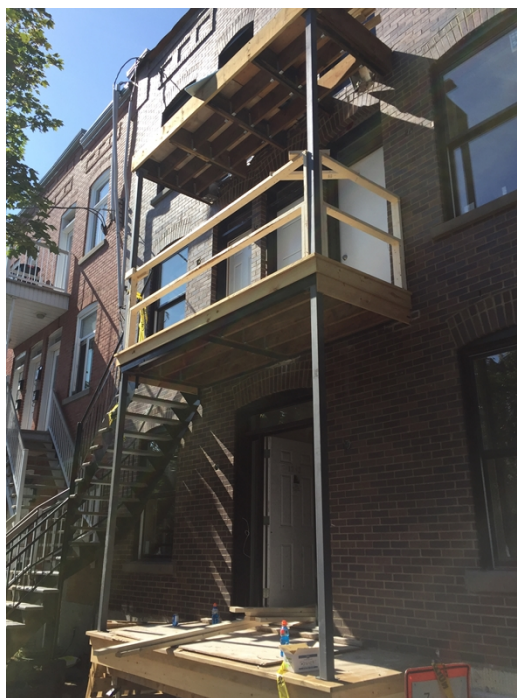
Photo 1. Une vue de la façade avant du bâtiment après installation des garde-corps au balcon du 1 er étage.
