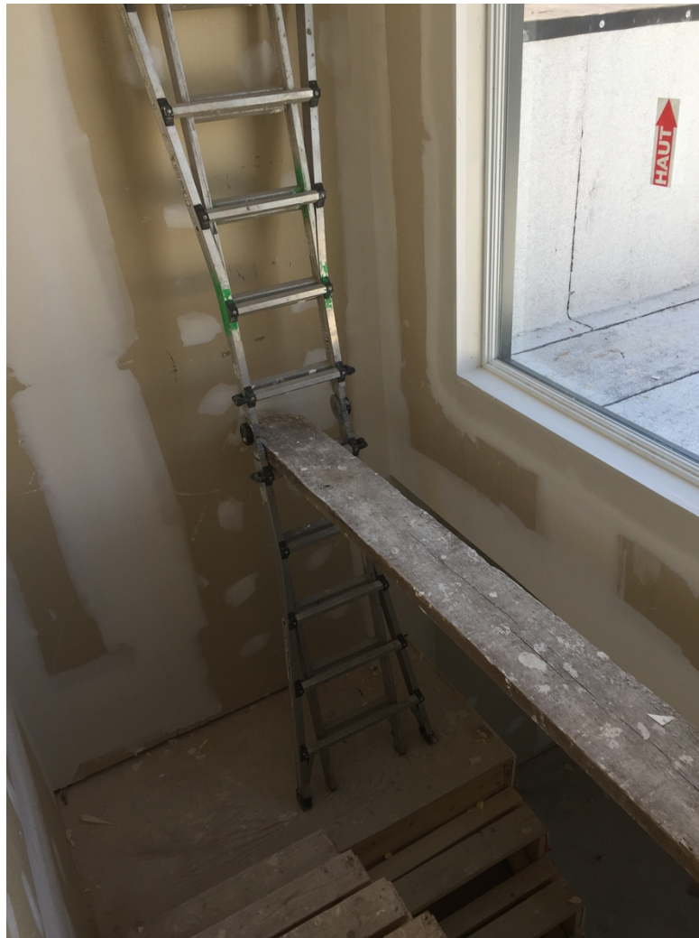
Photo 2. Dispositif utilisé par M. B pour les travaux de hauteur.
