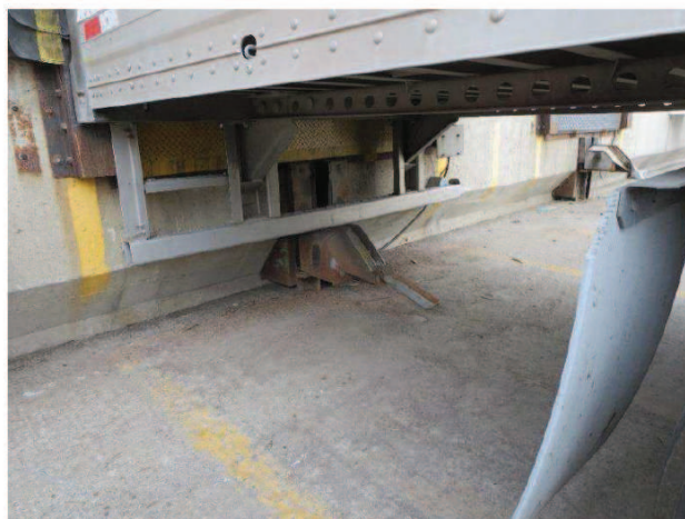
Photo 15 : Positionnement du dispositif de retenue, lorsque fonctionnel Source : CNESST
