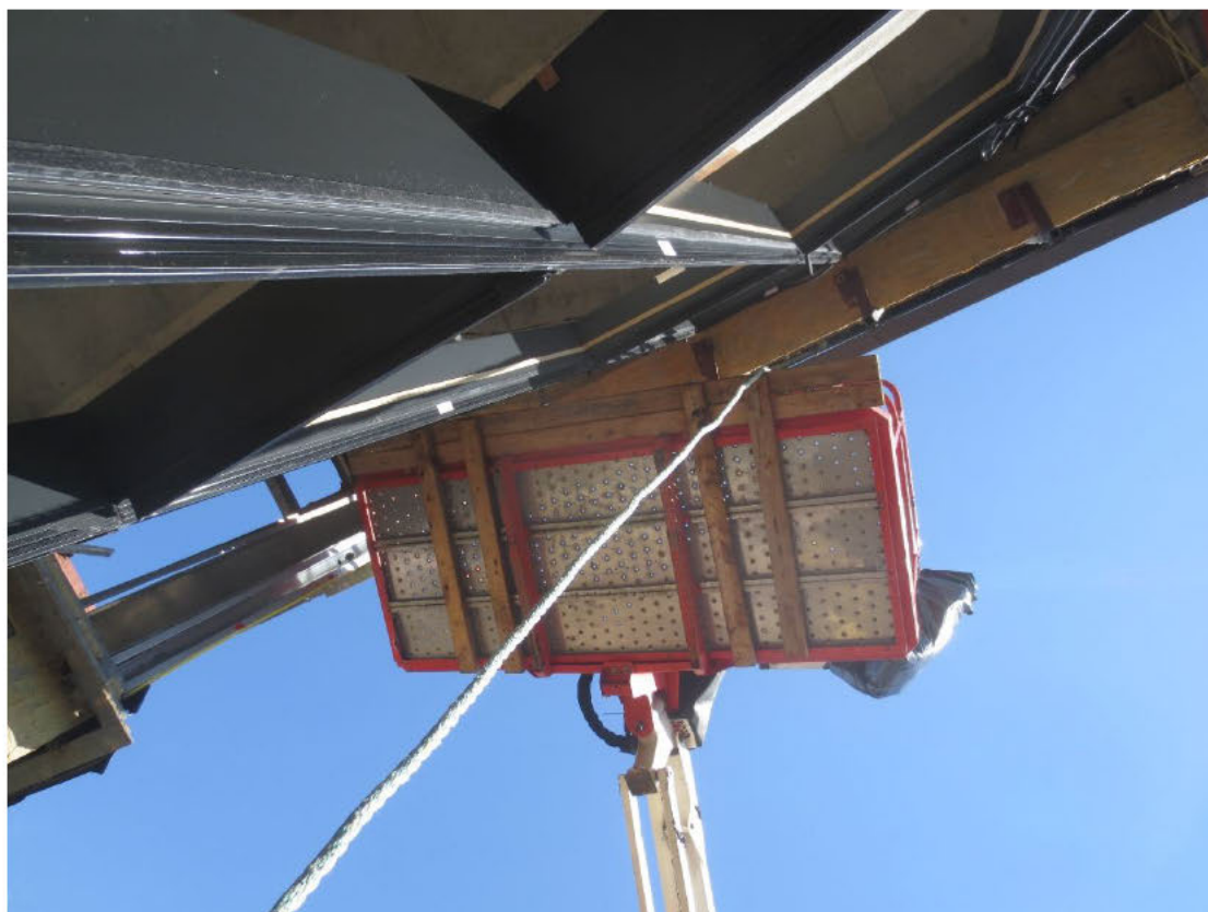
Figure 1- panier de l'appareil de levage vu par dessous, tablette maison à l'avant du panier
