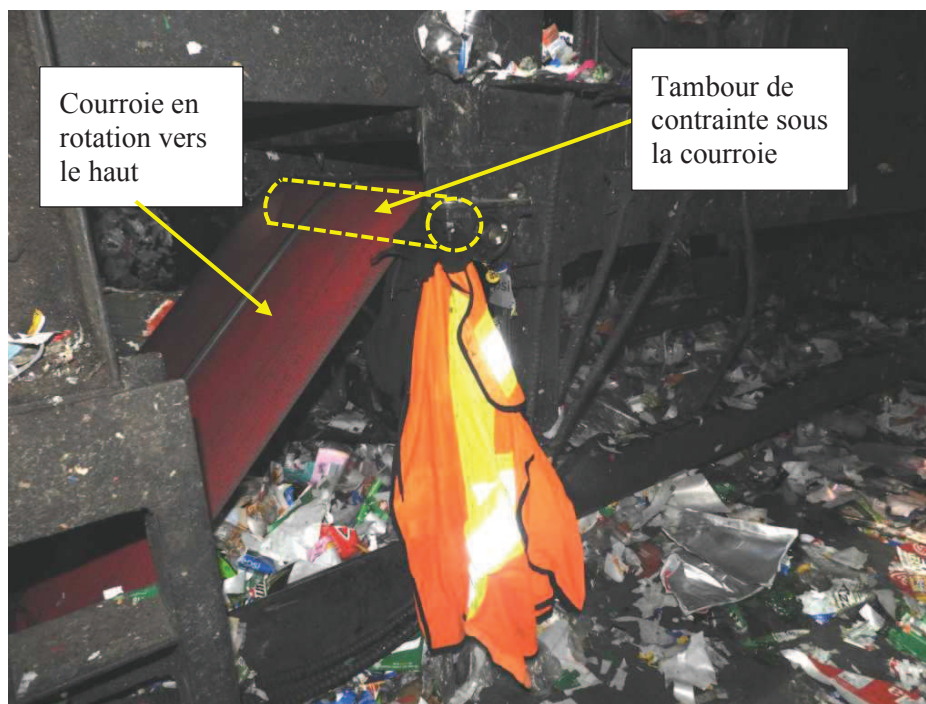
Photo 1 : Le convoyeur 1210 où l'accident est survenu
