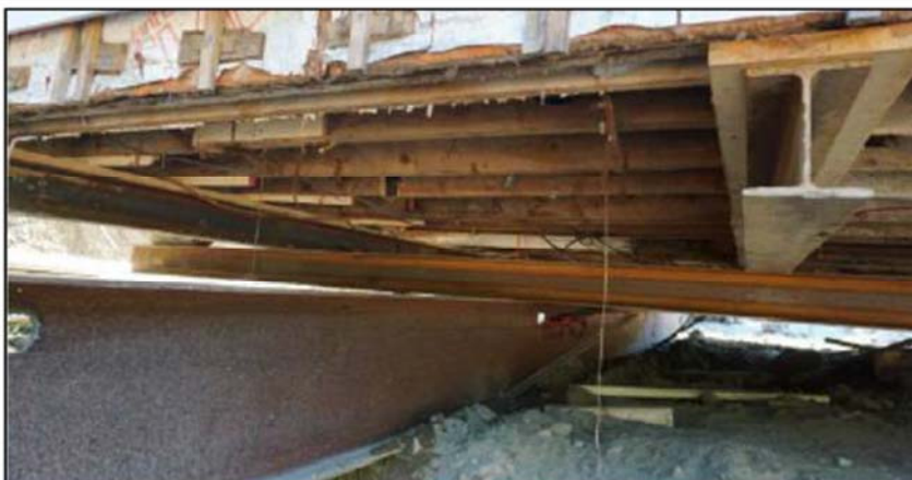
Photo 2 : Poutres superposées sous la maison (Source : CNESST)
