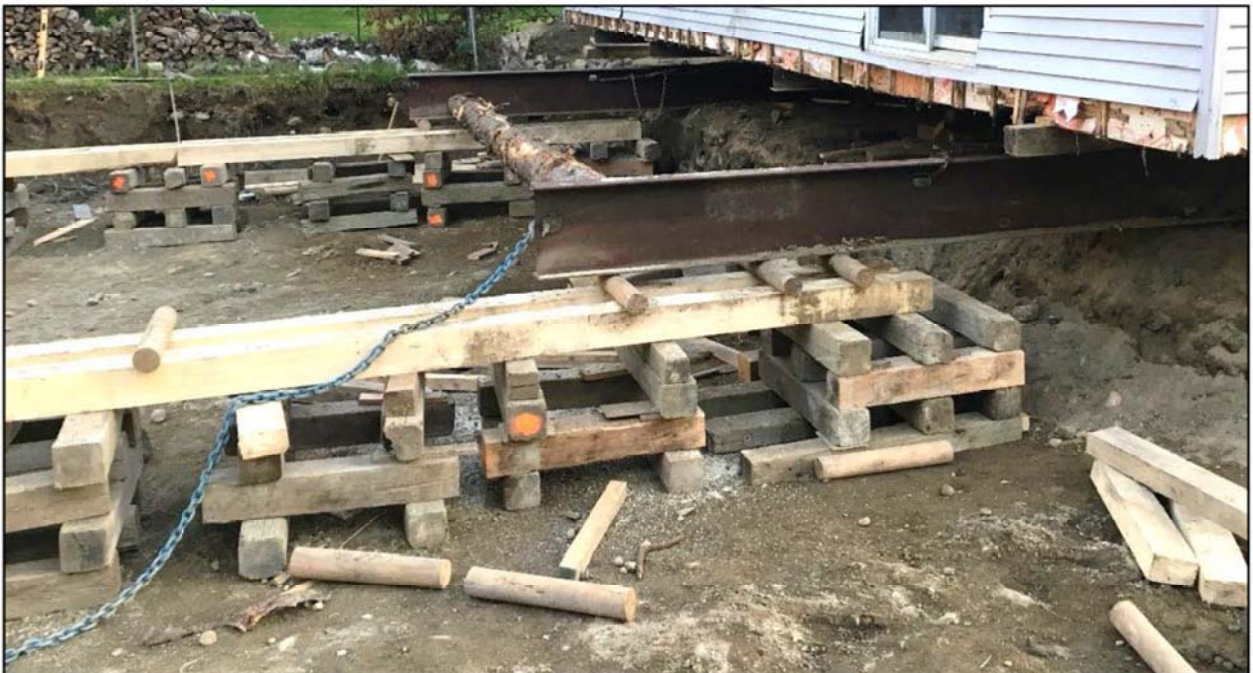
Photo 3 : Poutres d'acier sous la maison, cages et poutres de bois pour le roulement
