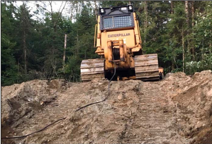
Photo 7 : Bouteur, treuil et câble d'acier (Source : CNESST)
