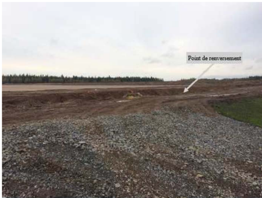
Figure 6 : Vue sur le chemin de la digue centrale à l'amorce du virage à l'est (Source : CNESST)
