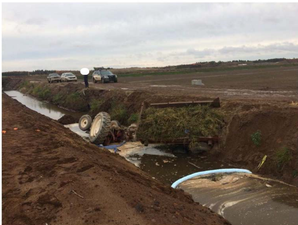
Figure 8 : Vue générale de la paroi sud du canal d'inondation central (Source : CNESST)
