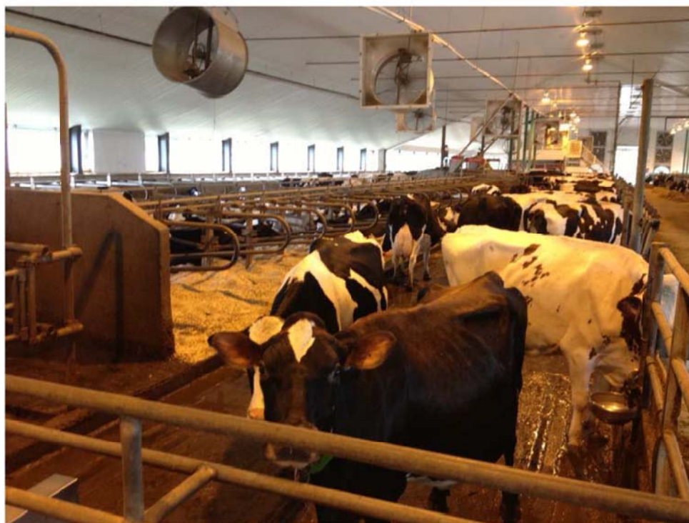
Photo 3 : Vue de l'intérieur du bâtiment avant son effondrement (Source : La ferme Pittet inc., modifiée par la CNESST)
