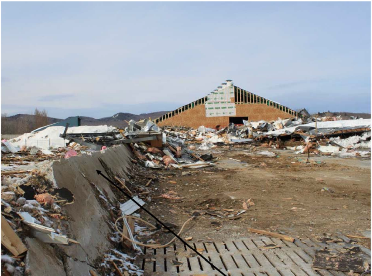
Mur de fondation versé vers l'extérieur
