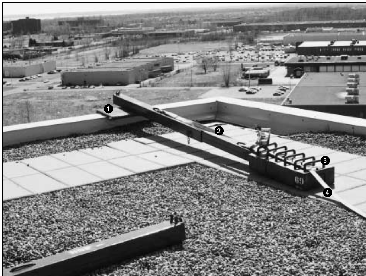
Console installée en porte-à-faux
