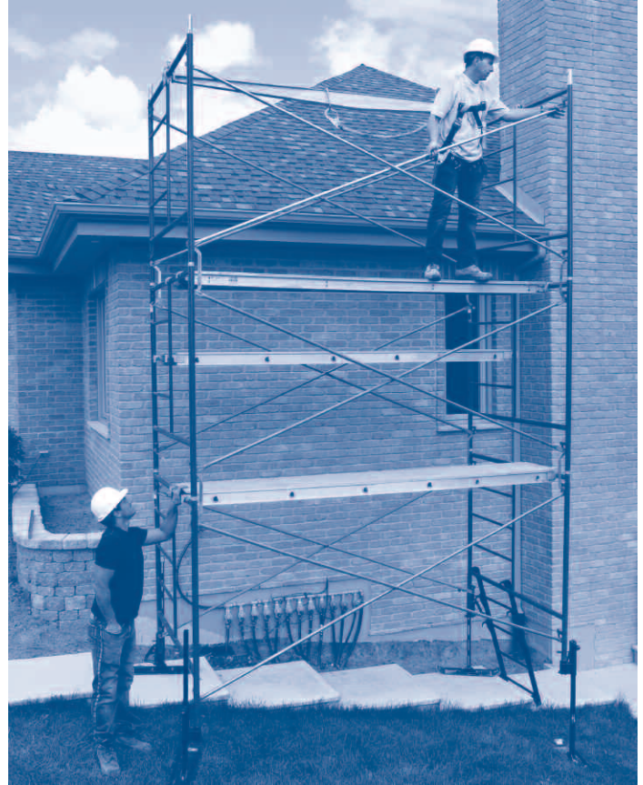
Figure 4 Corde d'assurance horizontale
